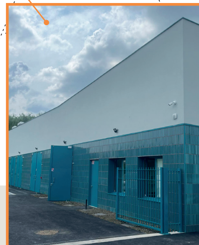
Chaudière d'appoint secours gaz
